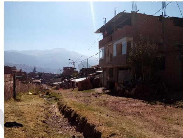
Imagen N° 63: Calle S/N 02 con canal abierto provisional de aguas pluviales
