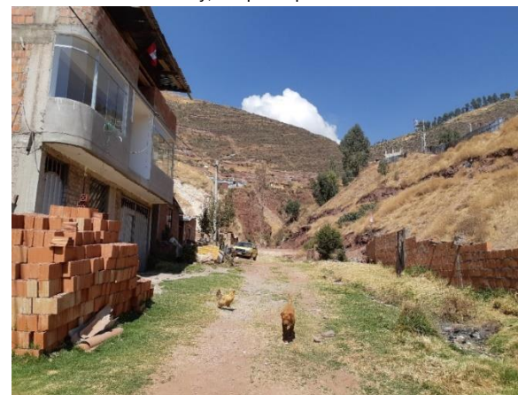
Imagen N° 31: Vista parcial de una sección de la margen izquierda de la quebrada Machutaucaray, se aprecia presencia remoción de tierras
