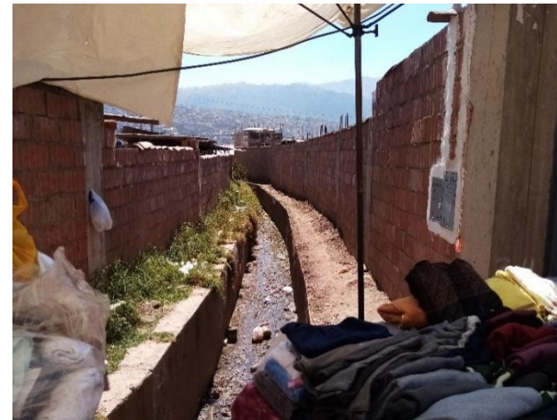
Imagen N° 64: Pasaje de servidumbre para canal de agua, ubicado entre las manzanas B y C del Sector denominado Quispiquilla
