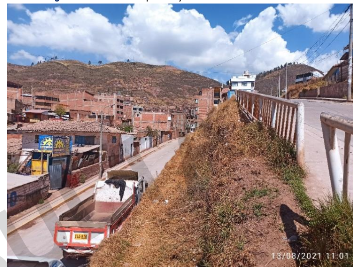
Imagen N° 27: Vista de la parte baja del ámbito de intervención de la ZRESS12
