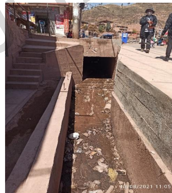
Imagen N° 42: Canalización del curso de agua de la quebrada Machutaucaray parte baja del ámbito de intervención de la ZRESS12
