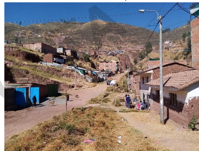
Imagen N° 60: Poste de alumbrado público instalado dentro de la acera disminuyendo y obstaculizando el tránsito peatonal
